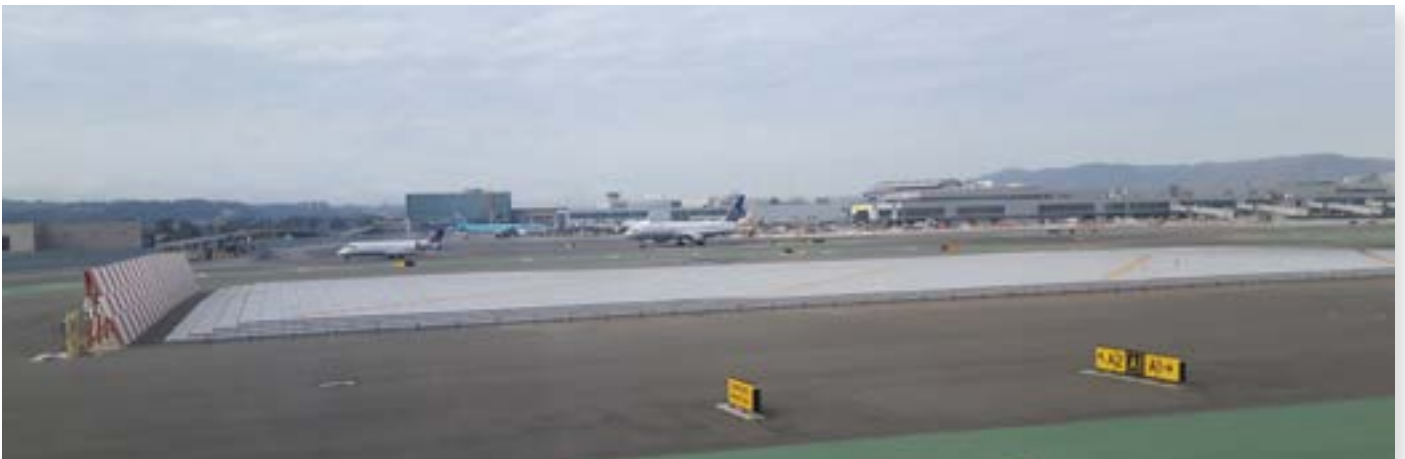
Hér má sjá EMAS stöðvunarkerfi á flugvelli í San Francisco // Engineered Material Arresting Systems in San Francisco. Photo/Ljósmynd: Ingvar Tryggvason.
