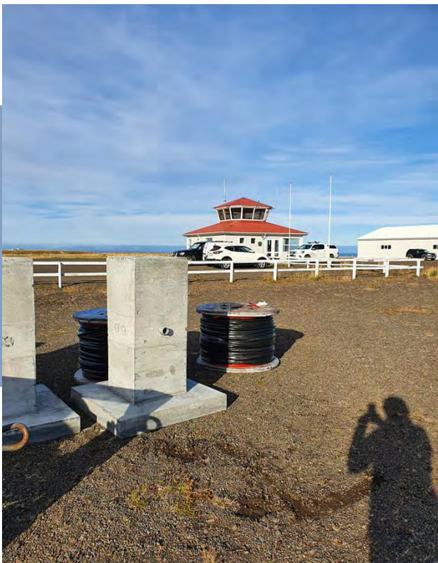
Uppsetning PAPI ljósa á Blönduósi - Hjördís Þórhallsdóttir, flugvallarstjóri á Akureyrarflugvelli tók mynd.
